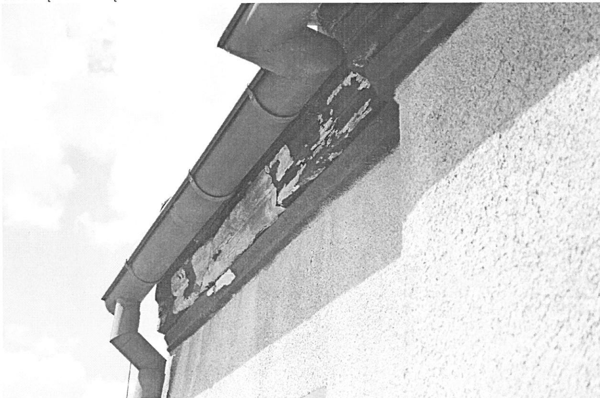
Fot. 7 – widoczne uszkodzenie gzymsu okapu spowodowane opadami atmosferycznymi i uszkodzoną obróbką blacharską.
