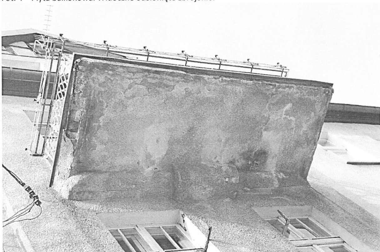
Fot. 4 – Płyta balkonowa. Widoczne odsłonięte zbrojenie.
