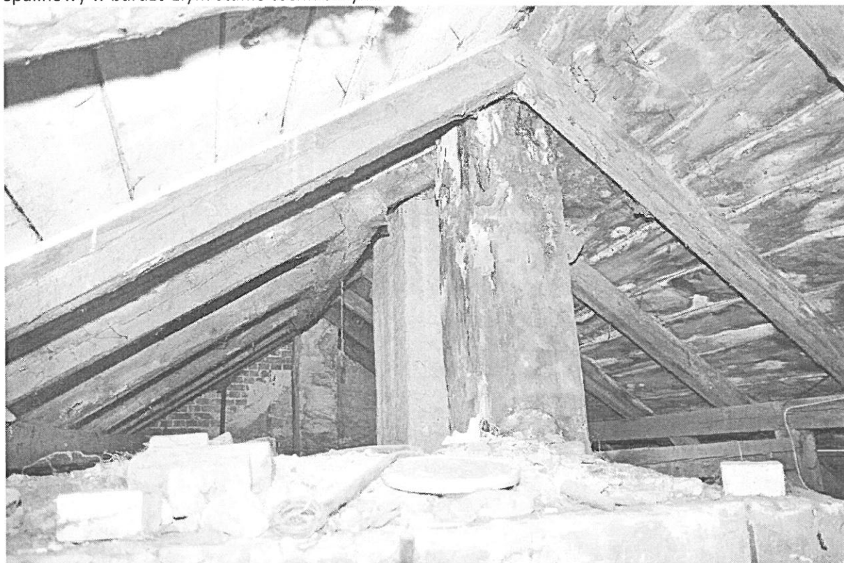
Fot. 8. Więźba dachowa – widoczne zawilgocenie i zagrzybienie elementów drewnianych oraz komin spalinowy w bardzo złym stanie technicznym.
